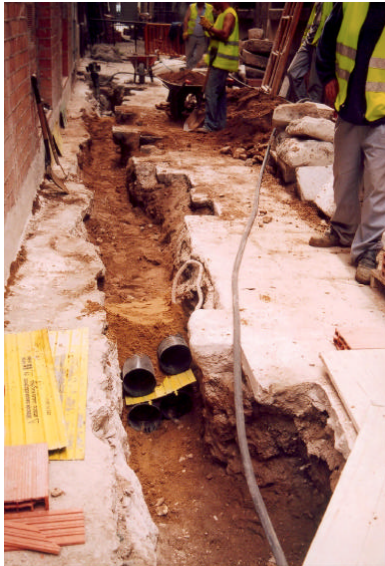
Foto 1: Vista general de la rasa al Passatge Palau
